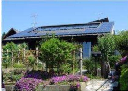
筆者自宅。屋根中央のガラスは屋根で受けた空気をさらに高温にする装置。屋根周囲はソーラーパネル
