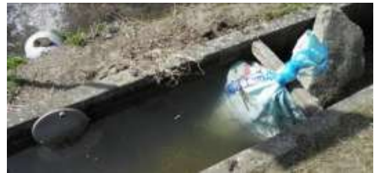
肥料袋の土嚢で水をせき止め田に水を入れる
